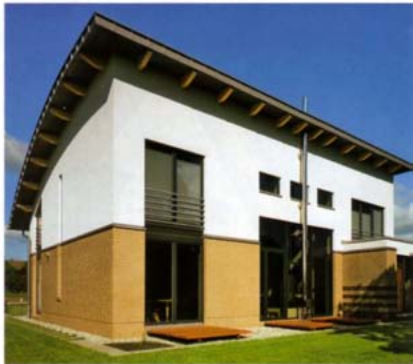
Die Rückansicht wird von dem spannenden Kontrast zwischen Putz- und Klinkerflächen geprägt. Hinter dem Vorsprung verbirgt sich das Esszimmer
